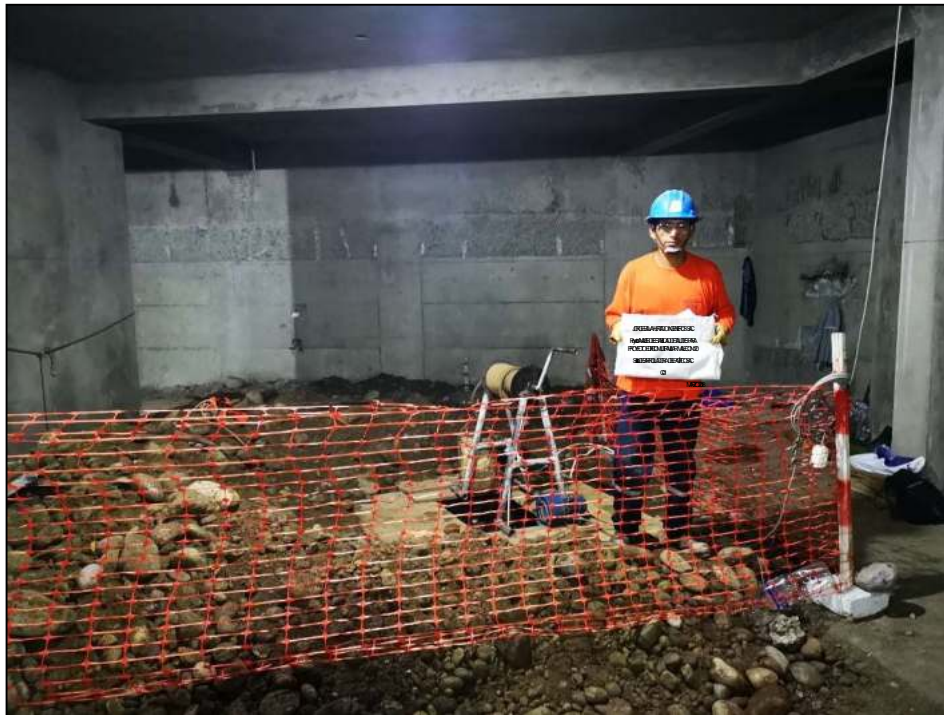
Foto N° 02: Vista de la ubicación de la Calicata C-01, donde se observa el material extraído durante la excavación.
