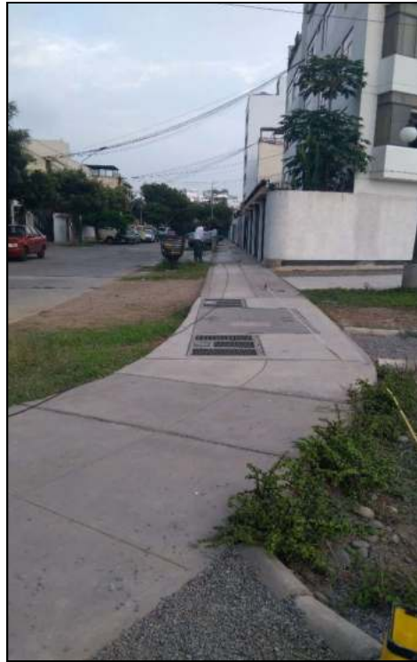
Foto N° 03: Investigación geofísica mediante el Método de Análisis Multicanal de Ondas de Superficie (MASW), donde se observa el tendido de la línea M1D-1, que tuvo una longitud de 66.0 m.
